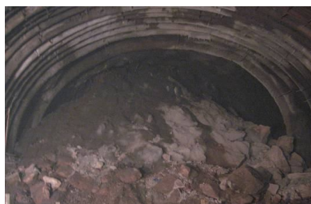
图 13 塌方现场治理
